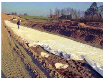
Р и с у н о к Г.6 – Устройство гибкого ростверка
